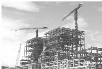
航和水运建设。
