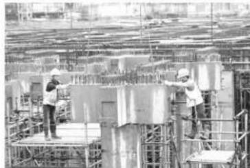
来说，白龙港污水处理厂地下空间采用的“搭积木”技术，在全国范围内名列前茅。新的全地下污水处理厂建成后，顶部要覆盖2米多厚的土层，种上绿化，凸显环保美观。□（戚颖璞/文）
