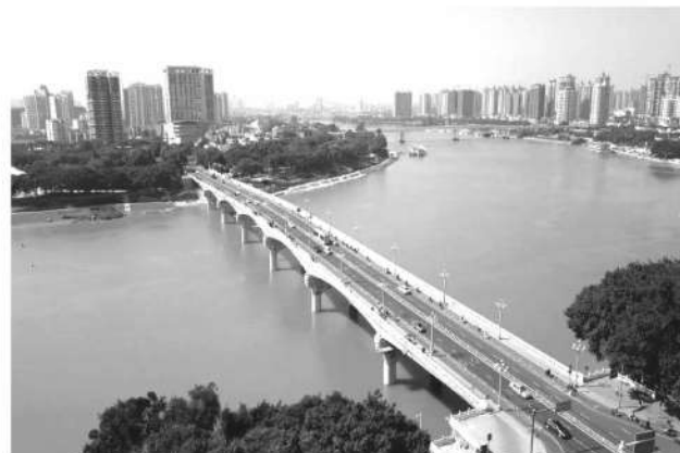
南宁邕江大桥
