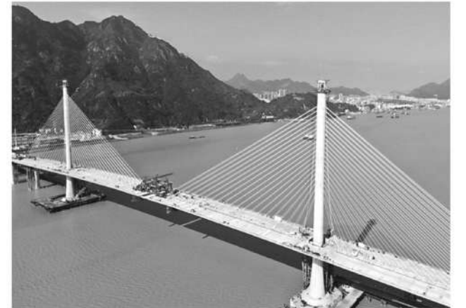
七都大桥北汊桥合龙
