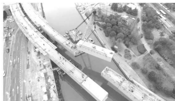
北虹路立交工程
