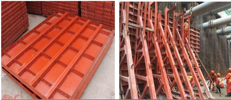
图 7.4.6 上海市轨道交通 10 号线二期 1 标段国帆路车站定型大钢模施工实景图
