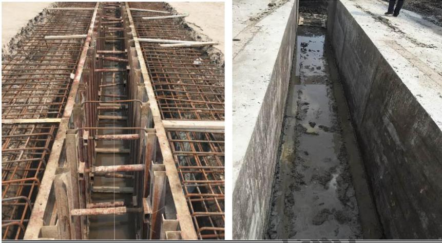
图 7.4.5 上海市轨道交通 10 号线二期 1 标段国帆路车站地下连续墙导墙实景图
