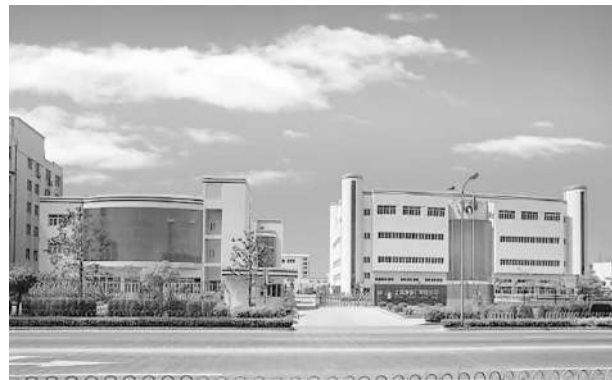
上海牙膏厂迁建主厂房工程
