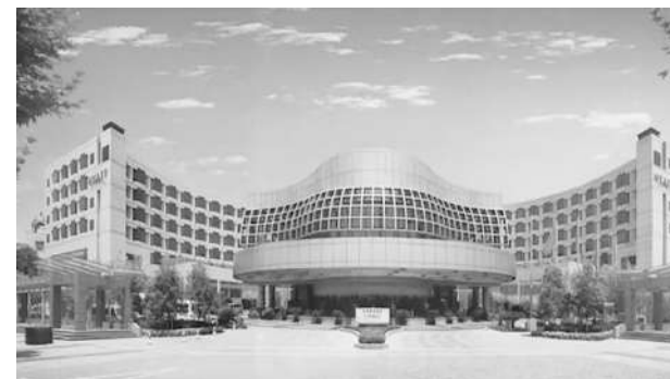
杭州西湖国际饭店(现为凯悦大酒店)工程照
