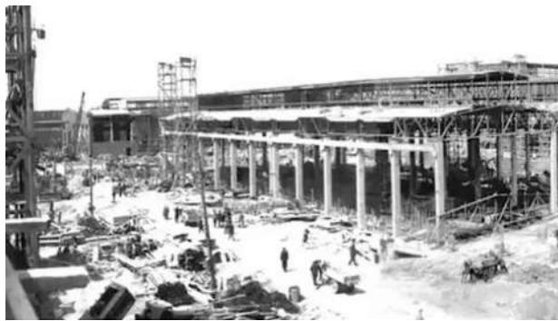
二〇二工程处施工的长春第一汽车制造厂厂房工程
