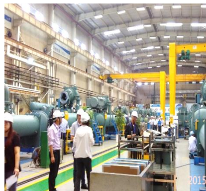
大型冷水机组监造
